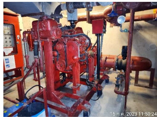
ภาพที่ 2-66 สภาพของห้องเครื่องปั้มน้ำดับเพลิงที่เหมาะสม และใช้งานได้สะดวก
